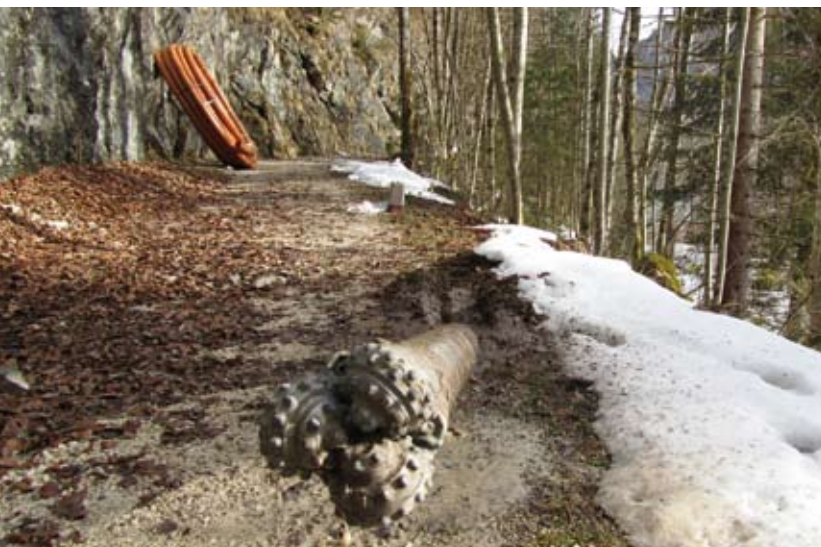
Pilotbohrung: Der Rockbreaker hat den Zielpunkt erreicht.
