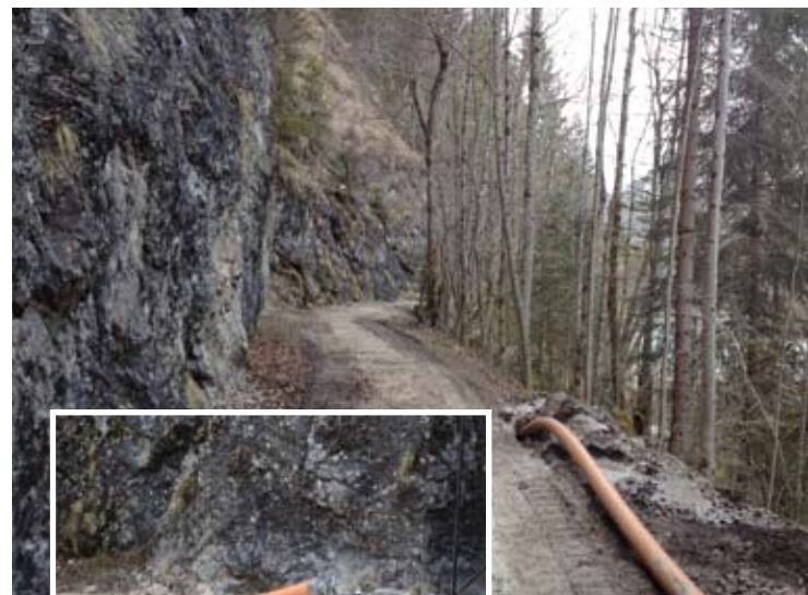
Einzug des PEHD Rohres.
